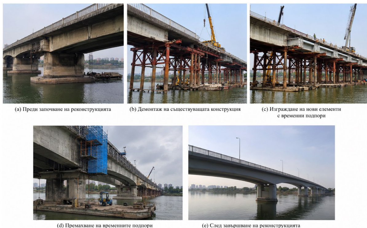
Фиг. 2. Основни етапи от реконструкцията на моста Shili, Китай (съставено от автора по материали от проекта).
